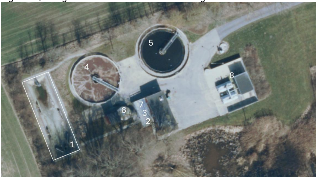
Figur 2 - Oversigtsbillede af Petersværft Renseanlæg
